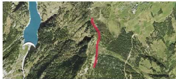
Abbildung 3 Google Earth Sicht auf die 1 km lange Schlauchleitung
