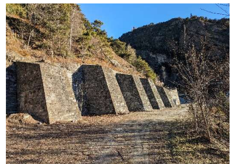
... und aussen die Stützmauer.
