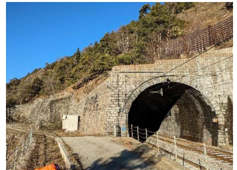
Wir sanieren den Sevisteintunnel innen...
