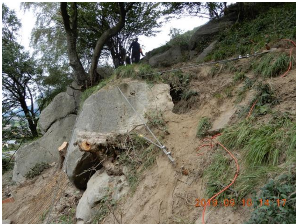
Photo 5 : Secteur Les Planches-Protorrent – Stabilisation de deux blocs par câblage réalisée en 2019
