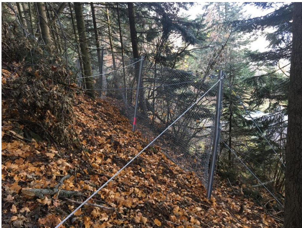
Photo 9 : Secteur Le Chanay – Une rangée de filet pare-pierres de 50 à 100 kJ posée en 2019
