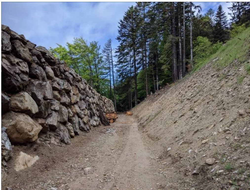
Photo 7 : Secteur La Teinda – Digue pare-pierres construite en 2019
