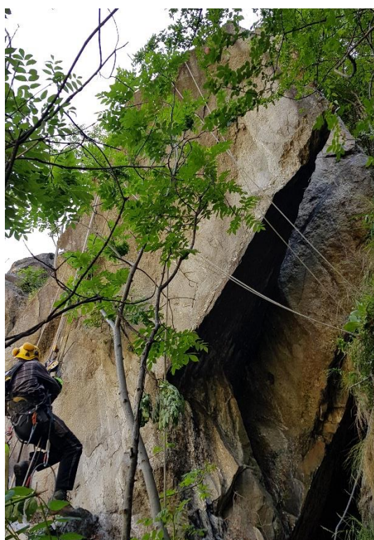
Photo 4 : Secteur Les Planches-Protorrent – Stabilisation d'un bloc par câblage réalisée en 2020
