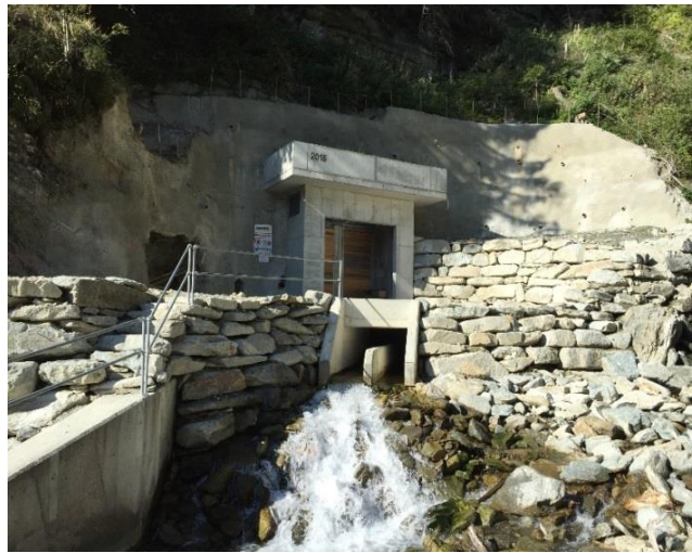
Portal Zugangsstollen zu Zentrale
