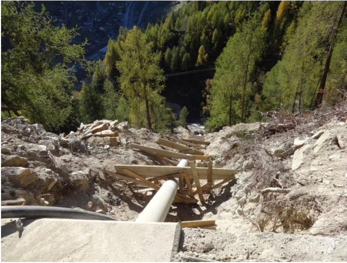
Montierte Stahlrohrleitung im letzten Abschnitt vor der Zentrale (Gefälle zwischen 80 und 90%)
