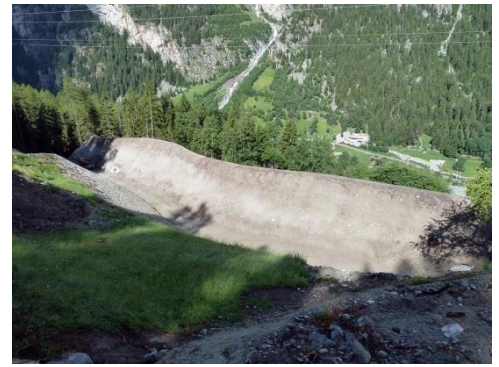
Schuttdamm Süd mit einer Länge von 120 m und einer Wirkungshöhe von 7.00 m.
