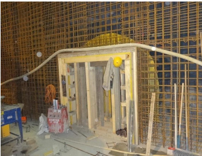
Wandarmierung in Kaverne
