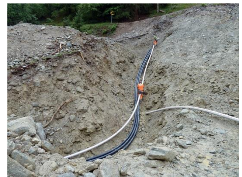
Ersetzen der bestehenden Trinkwasserleitung im Schuttdamm Nord.
