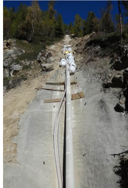
Montierte Stahlrohrleitung vom DL-Stollen aufwärts
