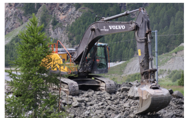
Bagger und LKW der Adolf Schaller AG (Schaller Group) bei den Aufräumarbeiten in Randa und Herbruggen – Quelle: Schaller Group
