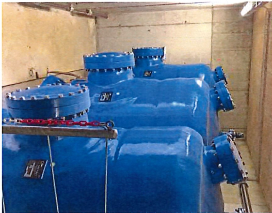
Arsen- und Uranfilter Mattsand
