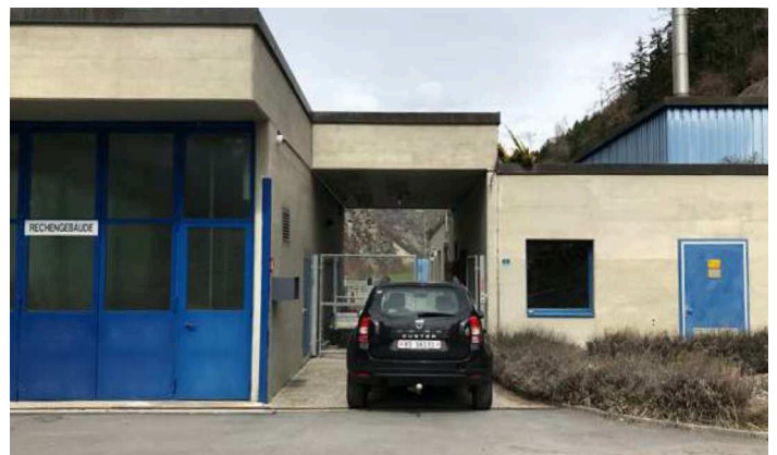
Vorgesehener Standort der neuen Befüllstation im Eingangsbereich der ARA an Südfassade
